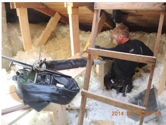
Bild 5. Tätningsstrumpa förs ned i kanal till kök i bottenvåning.
