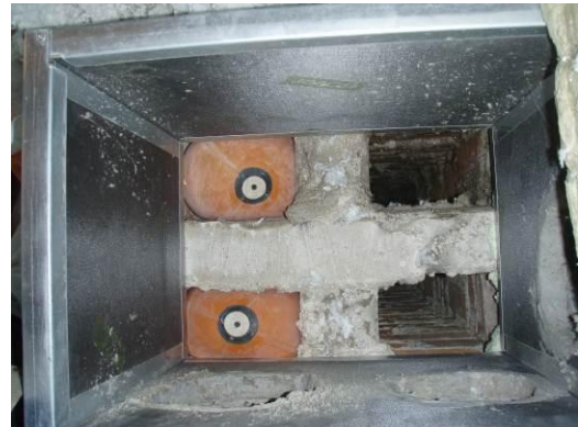
Bild 3. Suglåda med fyra kanaler. De vänstra betjäna kök respektive badrum i provad lägenhet på bottenvåning och har tätats provisoriskt med tätningsblåsor under täthetsprovningen.
