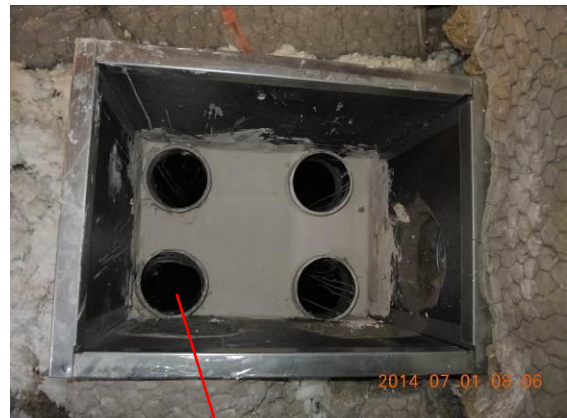
Bild 10. Frånluftskanaler med tättningsstrumpor efter färdigt montage.
