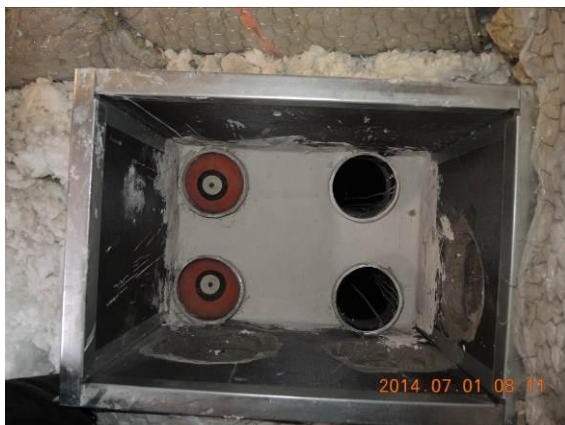
Bild 11. Efter att tättningsstrumpor monterats utfördes ny täthetsprovning.
